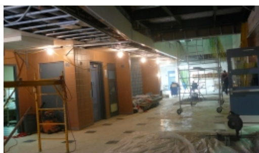
L'ajout de deux locaux pour le service de garde a nécessité des travaux majeurs.
